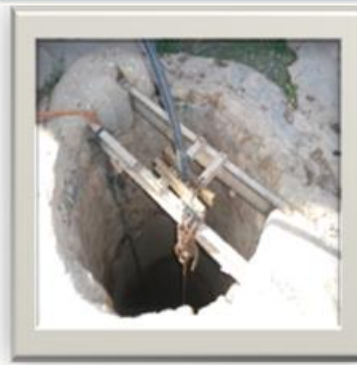
Boren van de put en installeren van een waterpomp
